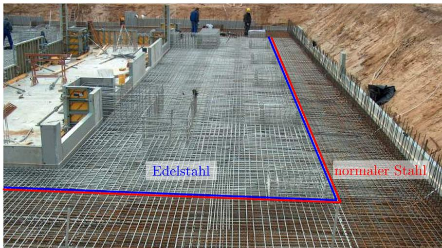
Abbildung 4.3.: **Armierung des Hallenbodens:** Unter dem Spektromertank wurde Edelstahl verwendet, für den Rest normaler Baustahl.
