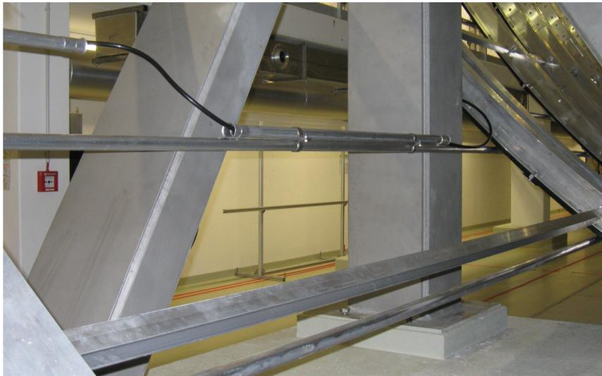
**Abbildung 3.12.:** Foto der Umgehung des EMCS-Kabels. Zu sehen ist der detektorseitige Sockel auf der Ostseite und das Kabel der EMCS-Y-Ebene 3.
