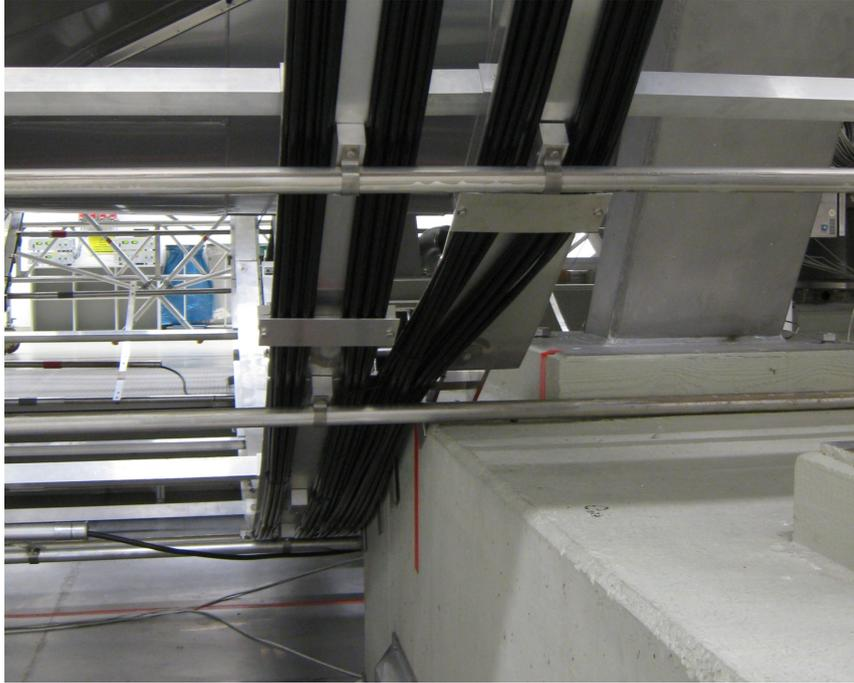
**Abbildung 3.11.:** Foto von Spule LFCS14 im Bereich des Betonsockels. Auf Grund des Betonsockels konnte der Aluminiumring nicht in seiner ursprünglichen Form fortgeführt werden. Unterhalb der LFCS-Spule ist die Umgehung des untersten EMCS-Y-Kabels um den Betonsockel zu erkennen.
